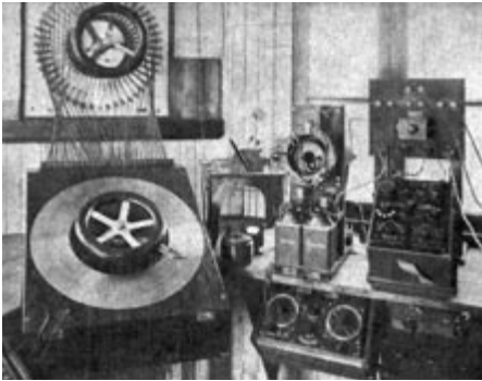
Bild 5: Sternpeiler mit 48 schirmförmig ausgespannten Langdrahtantennen von je 60 m Länge, Schleifgoniometer (Mitte) und Empfangsanlage (rechts), um 1918, nach [1].
