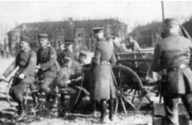
**Bild 19:** *Kleinfunk 17 im Ersten Weltkrieg (etwa 1917). Die beiden tretenden Funker brachten 250 W an ihren Sender, aus [31].*
