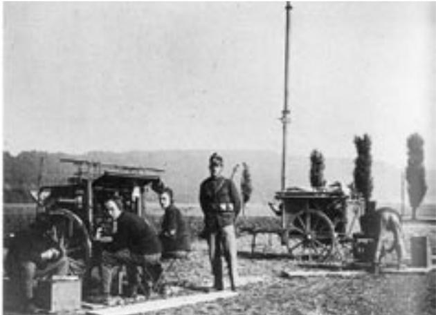
**Bild 20:** *Fahrbare leichte Funkenstation 19 der Schweizerischen Funkertruppe (Telefunken Gfuk 18: 400-W-Löschfunktensender 0,4 TV 150-1600 m, Röhren-Audion-Empfänger E 213 a), aus [27].*
