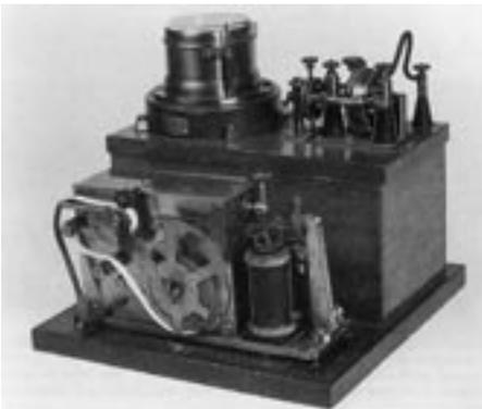
**Bild 4:** *Schreibempfänger nach BRAUN (um 1902): Oben links die abstimmbare Drahtspule, rechts Kohärer mit Klopfer, vorn Morse-schreiber und Relais, aus [31].*
