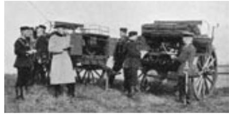
**Bild 10:** *Militärische Funkstation im Betrieb (etwa 1906): links Protze mit Sender und Stromerzeuger, davor ein Funker, der den Ballon mit Antenne beobachtet, rechts Empfangswagen mit Morseschreiber, aus [3].*
