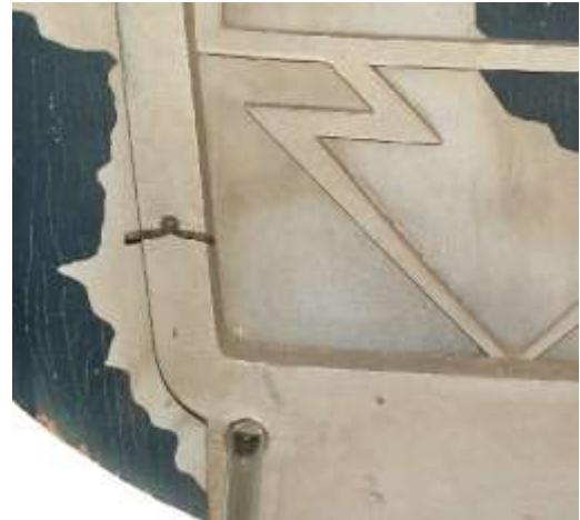
Detailansicht: Halterung der Neonröhre
