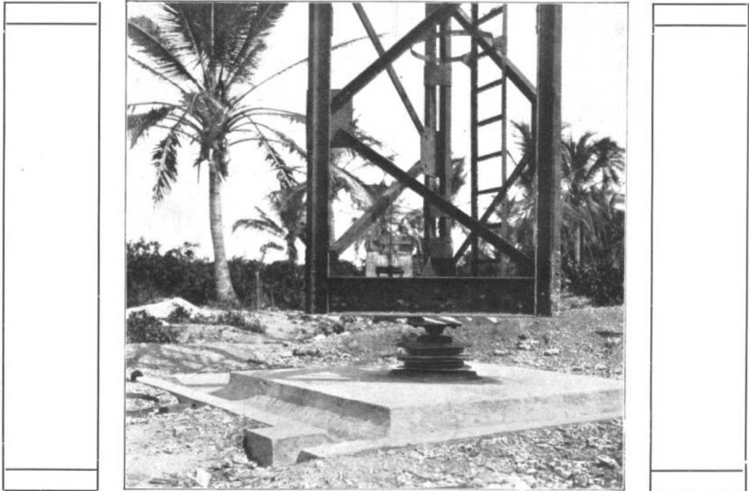
Abb. 32. Turmfuß eines 60 m-Mastes der Telefunkenstation Cartagena.
