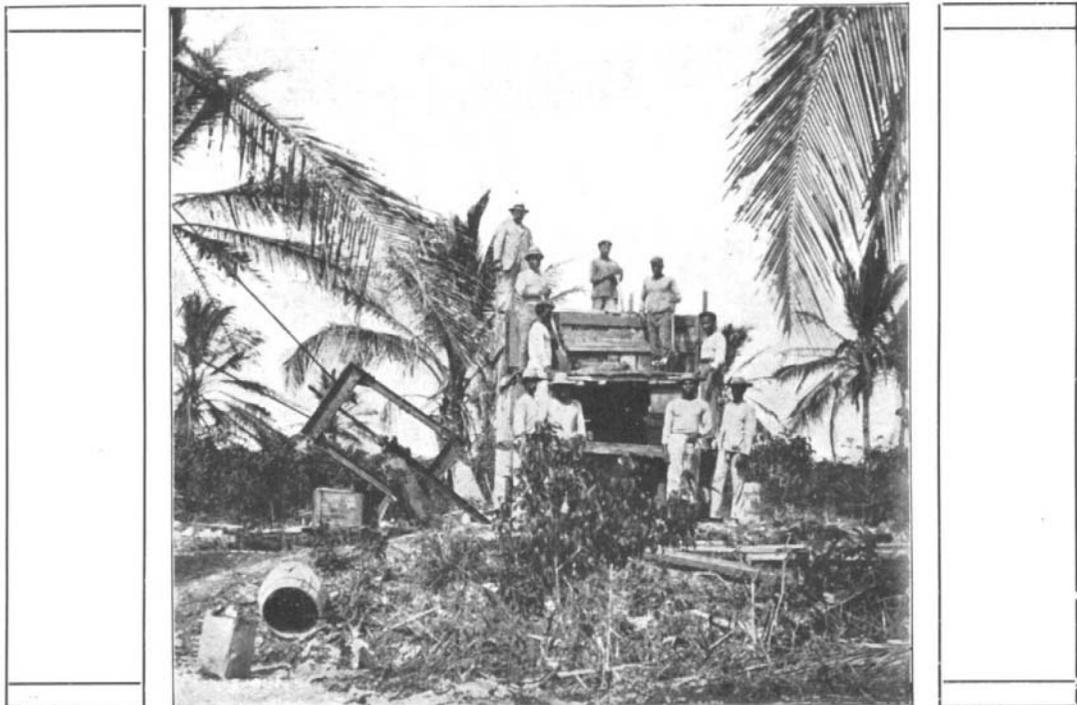
Abb. 33. Verankerung eines 60 m-Mastes der Telefunkenstation Cartagena.
