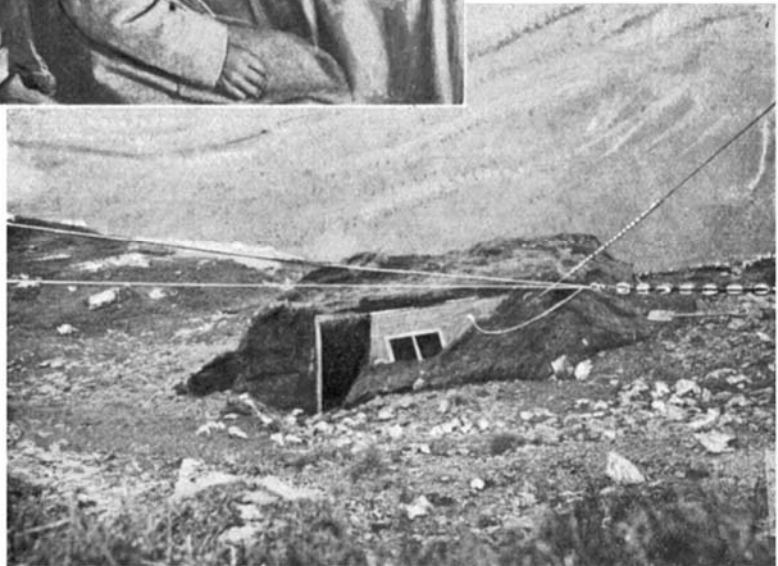
Bild 67. Außenansicht derselben Station
