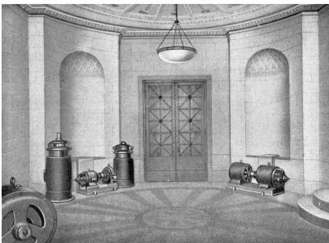
Bild 6. „Die Generatoren zu den großen Schiffstationen . . .“
