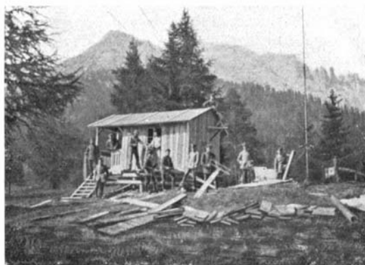
Bild 84. Bau eines Funkhauses - Balkan
