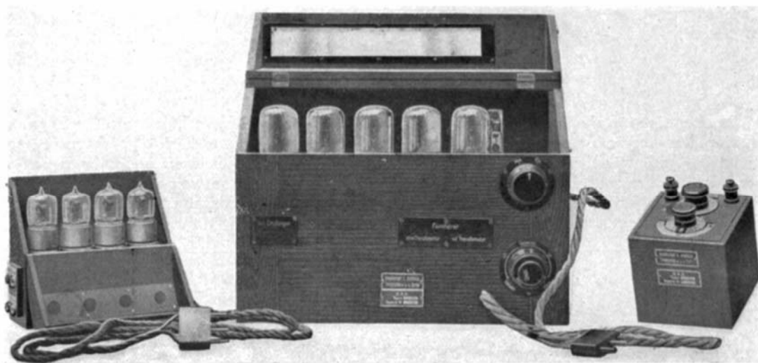
Bild 52. Verstärker und Abstimmkondensator für Rahmenempfang
