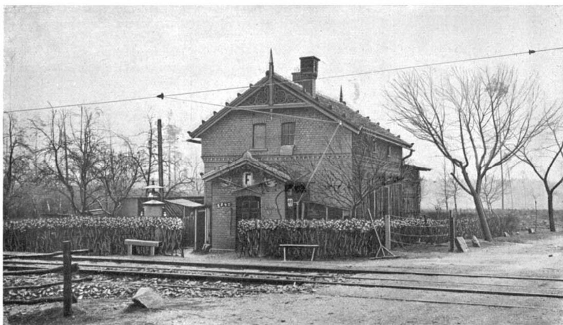
Bild 36. Antenne eines Bahnwärterhauses
