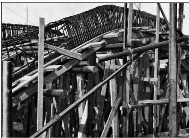
Bild 16. Bau eines Beton-Dachbinders des Sendergebäudes (Assel)
