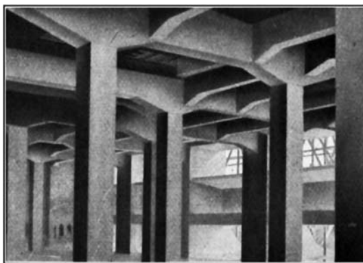
Bild 14. Betonpfeiler des Kellergeschosses (Assel)
