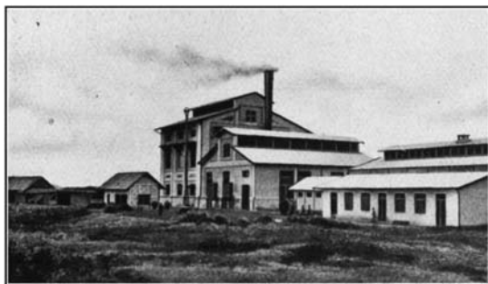
Bild 17. Kraftwerk Dajeuhkolot der Großstation Malabar auf Java
