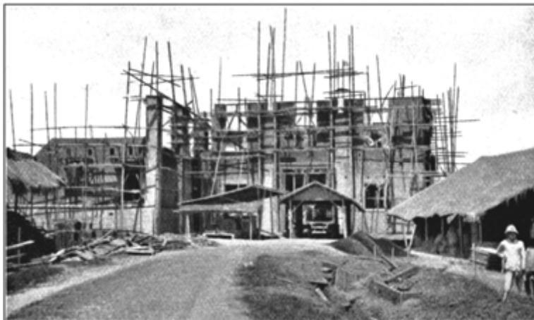
Bild 48. Vom Bau des Kraftwerkes Dajeuhkolot, Maschinenhaus im Bau
