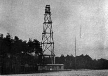
Bild 5: Die zusammengeschnittene „Draht-l/p“ wurde auf dem Thurauer Berg zwischen einem 30 m hohen (selbst erbauten) Holzturm und dem „Maibaum“ (auf dem Foto rechts) aufgehängt. Hier wurde später aus 1000 t Stahlbeton der Fernmeldeturm B errichtet.
