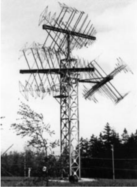
Bild 8: Die „Interims-VHF-Antenne“ HL 017 der Firma Rohde & Schwarz.
