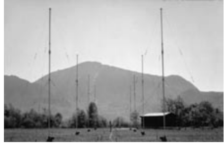
Bild 1: Aus „Alraunen“ zusammengesetzte HF-Richtempfangsantenne A 195 der Firma Telefunken
