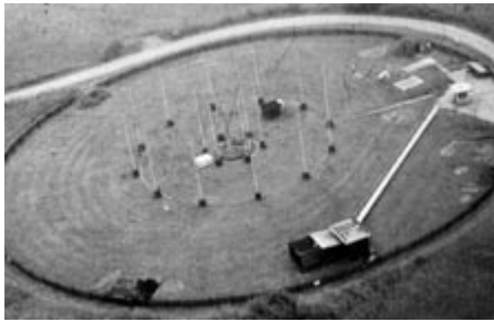
Bild 13: Sieht es nicht aus, als sei hier vor kurzem erst eine „fliegende Untertasse“ gestartet? Ortsfeste Kurzwellenpeilstelle der Bundeswehr mit 8-Element-Adcockantenne - hier stört noch nicht einmal der Zaun die Symmetrie der Anlage!
