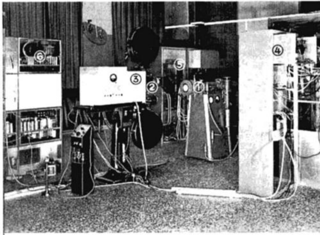
Fig. 6. Die Fernsehanlage bei der Montage im Laboratorium
