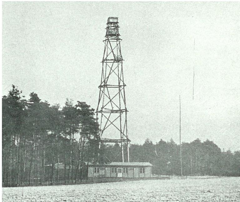
Von einem Artilleriebataillon errichteter Holzturm auf dem Thurauer Berg im „Dannenberger Zipfel“. Rechts davon der Baumstamm, zu dem die L/P-Drahtantenne abgespannt war
