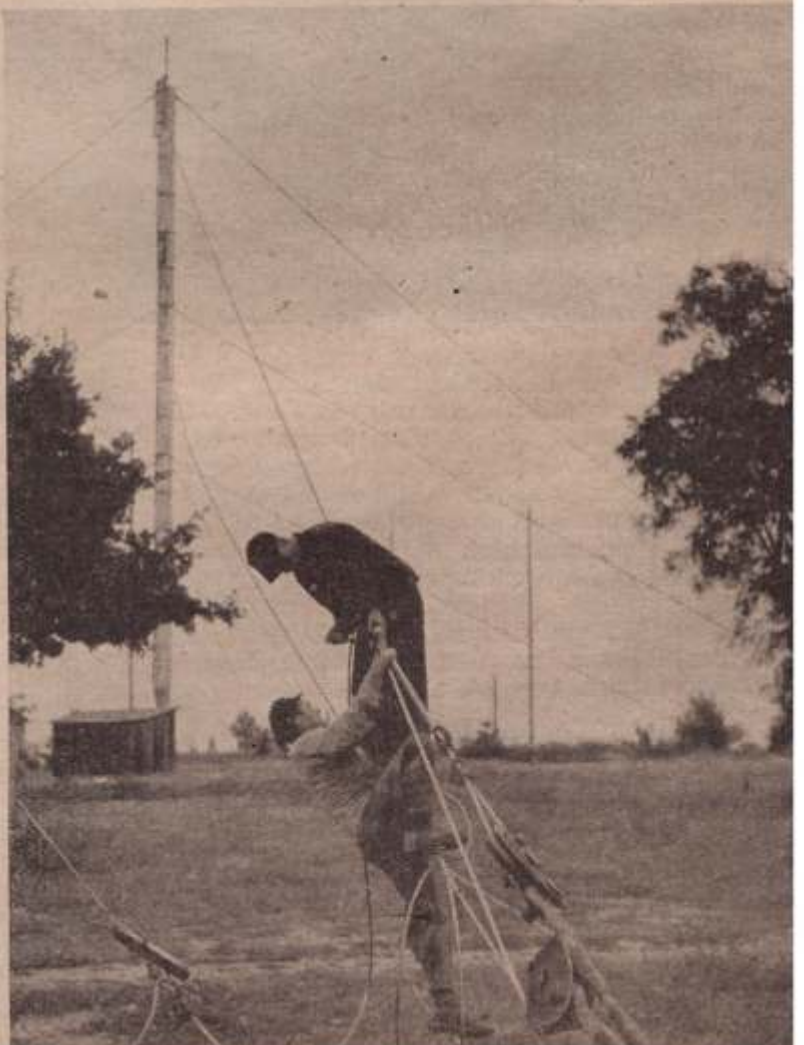
Die Montage des Rohrmastes erfolgt mit Hilfe eines an der Außenwand fahrbaren Gerüsts, das mit seiner Länge von bald vier Metern die Höhe der einzelnen Rohrenden erheblich überragt. Im Rohrrinnern werden die Sendeenergiekabel, eine Sprossenleiter, ein Telefonkabel sowie eine Lichtleitung hochgeführt
