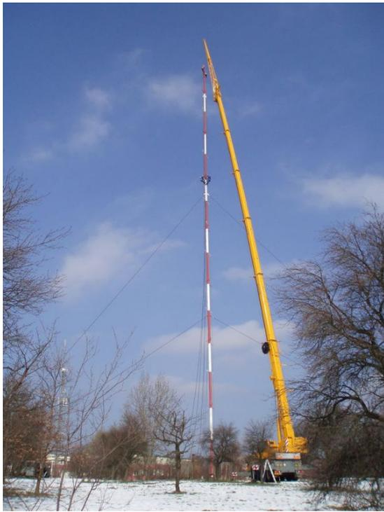
*Bild 15 Demontage des Antennenmastes*
