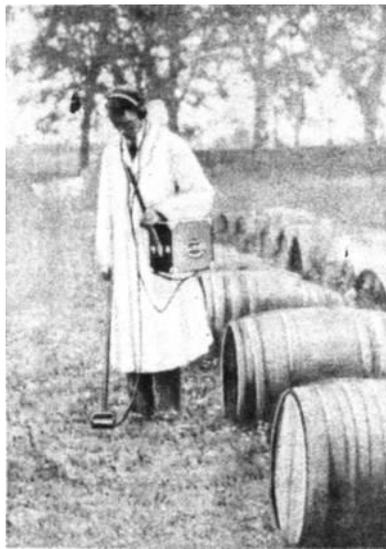
Abb. 13. Ein neues Suchgerät von Siemens dient zur Auffindung von Kabeln und stromführenden Leitungen im Erdboden.
