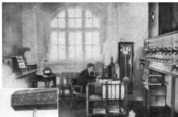
Links im Verstärker- und dem Vorverstärker (Detektor mit Verstärker), rechts eine zweite Kontrolluhr und anschließend ein Teil der Starkstromschalttafel
