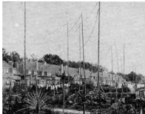
— Und wie es nicht sein sollte: Die Antennen stören sich gegenseitig — und schön ist die Anlage auch nicht.
