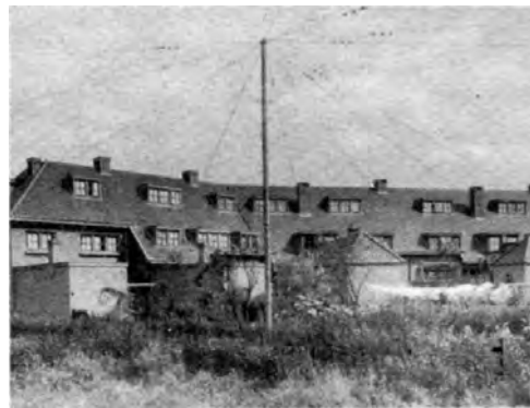
Ein vorbildlicher Antennenmast in der Philips-Gartenstadt Eindhoven.
