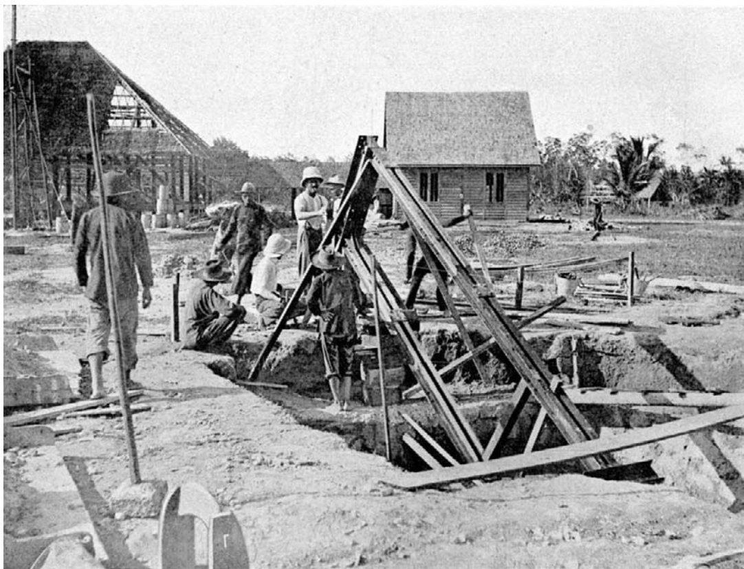
Bild 44. Fundamentierung einer Mastabspannung in Sandakan
