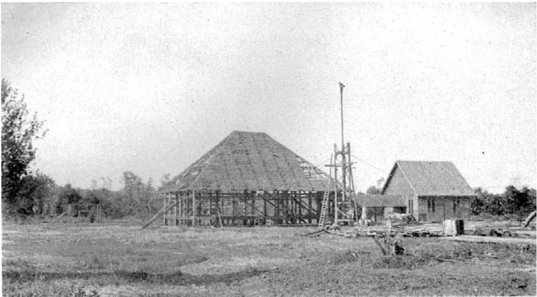
Bild 42. Telefunkenstation Sandakan im Bau
