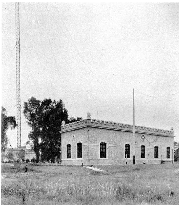
Bild 13. Stationsgebäude der Telefunken-Großstation Chapultepec
