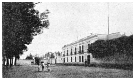
Bild 16. Ixtapalapa, Empfangsstation der Telefunken-Großstation Chapultepec
