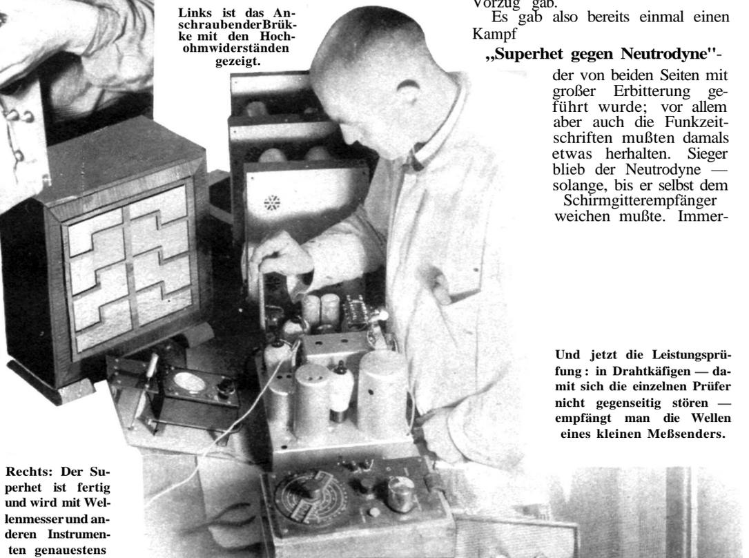
Und jetzt die Leistungsprüfung: in Drahtkäfigen — damit sich die einzelnen Prüfer nicht gegenseitig stören — empfängt man die Wellen eines kleinen Meßsenders.
