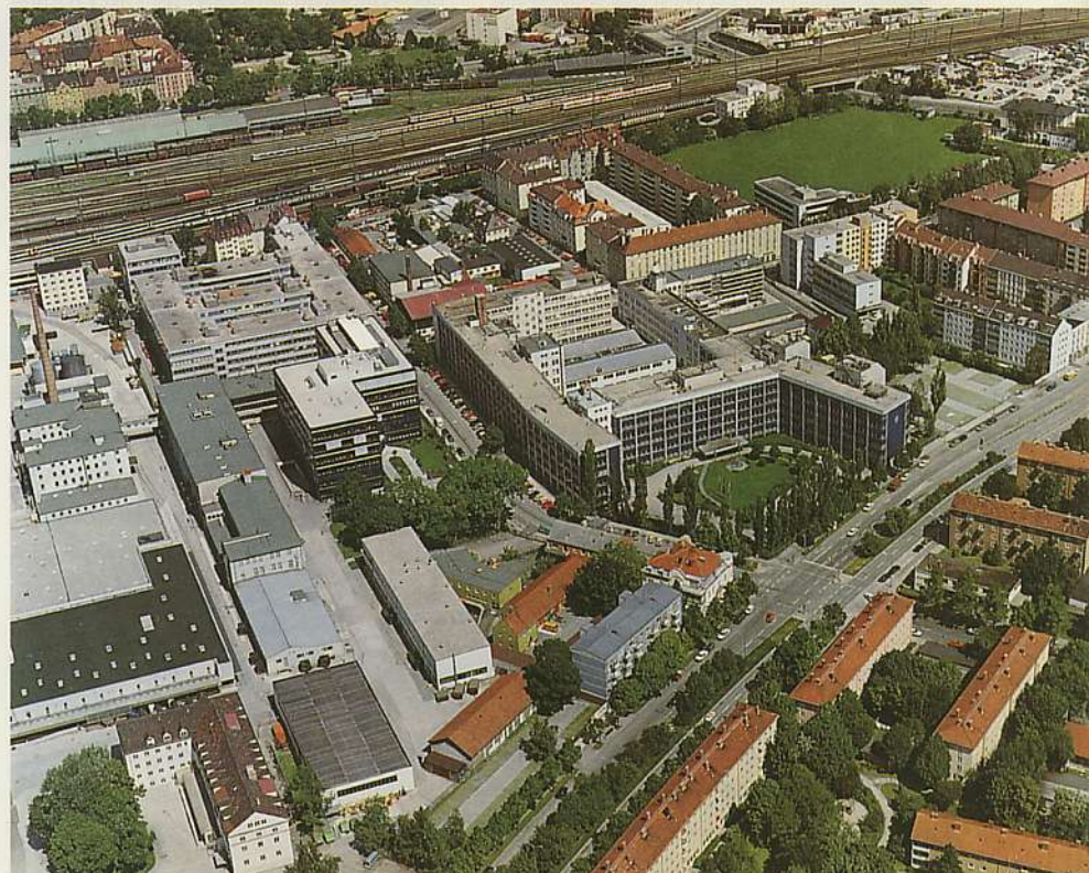
Das Firmengelände von Rohde&Schwarz an der Mühlendorfstraße in München
