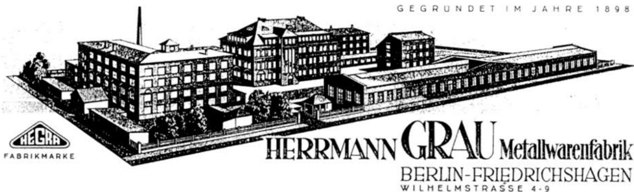
Bild 1: HEGRA-Fabrikgebäudeensemble (um 1938/39) enthält die Abteilungen Konstruktion, Werkzeugbau, Stanzerei, Metalldruckerei, Dreherei, Schleiferei, Lackiererei, Galvanik, Versand und Acetylen-gas-Erzeugung.
