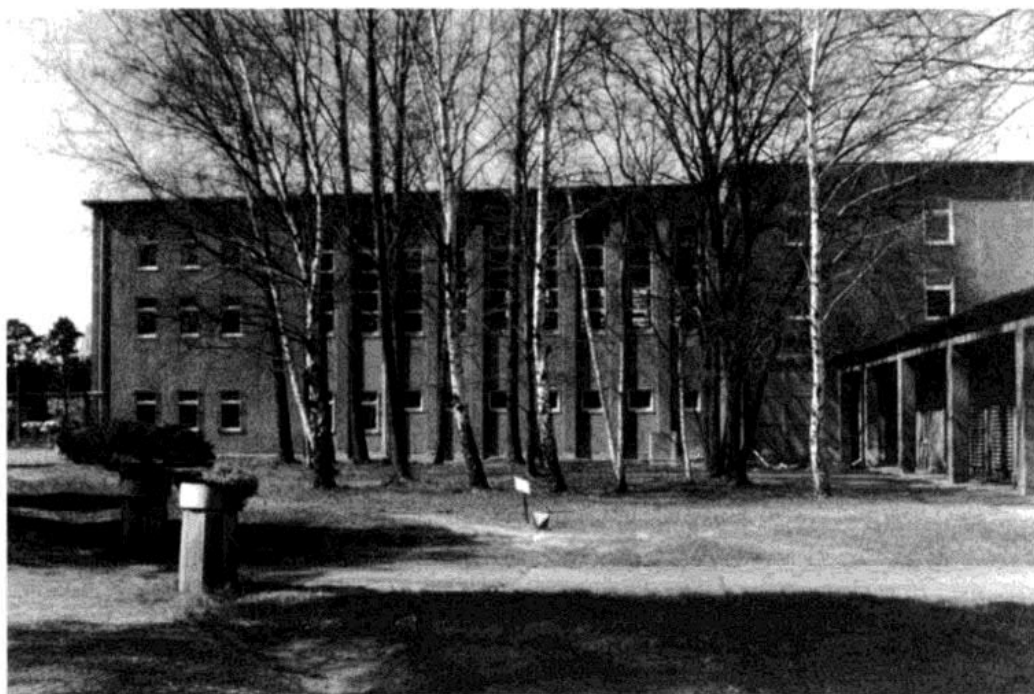
Altes Dieselgebäude (oben) und Ostseite des alten Senderhauses (rechts).
