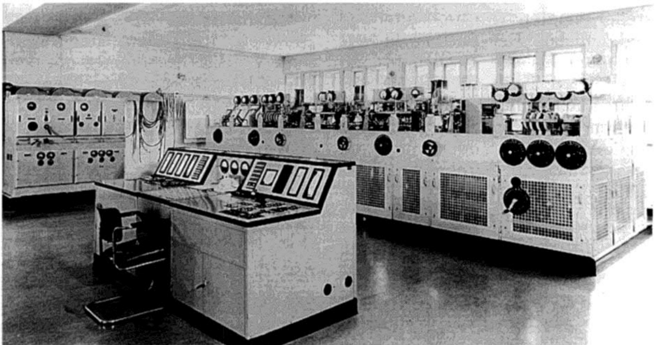
Bild 1: Durchstimmbarer 100-kW-Mittelwellensender „Umbausender“ der C. Lorenz A.G. (1939).
