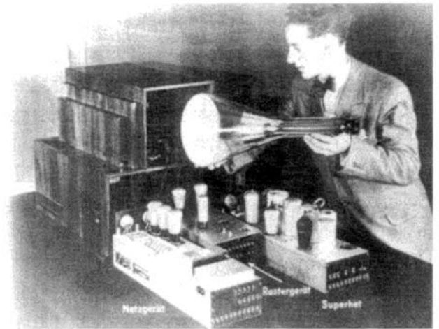
Bild 5: Fernsehempfänger der Radio A.G. D.S. Loewe (1934) in moderner Bauweise. Das rechte Chassis enthält den UKW- und ZF-Teil (Superhet).
