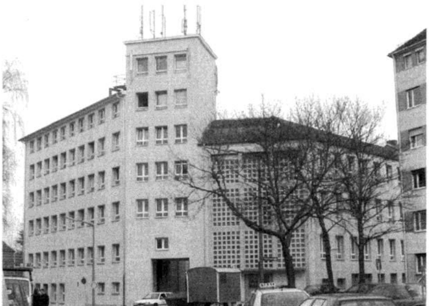
Bild 1: Ansicht des ehemaligen Lumophon-Gebäudes mit neuen Sendeantennen.
