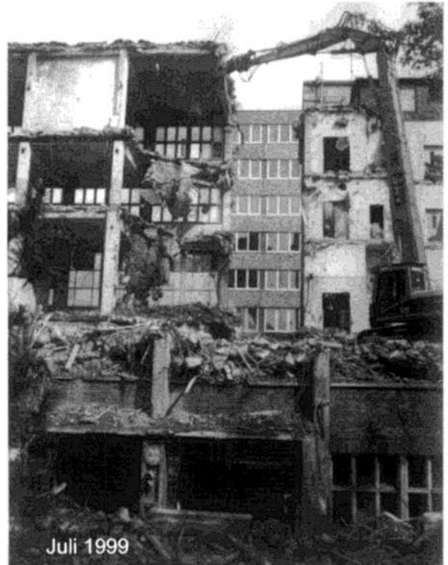
Bild 10: Der Bagger auf dem ersten Stock der „maroden“ Bausubstanz.
