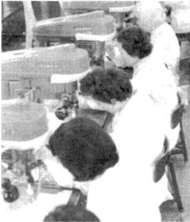
Bild 4: In den Anfängen der Leiterplatten-Produktion war Handarbeit noch gefragt: Vornehmlich Frauen bedienten die in langen Reihen angeordneten Säulenbohrmaschinen zum Bohren der Löcher für die Anschlussdrähte der Bauelemente.
