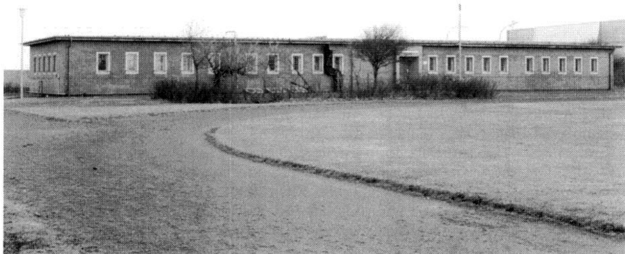
Bild 2: Gebäude vier der ehemaligen Marinefunkstation Borkum, als das Gelände nach Kriegsende von der Fernmeldezentrale der Bundeswehr genutzt wurde.
