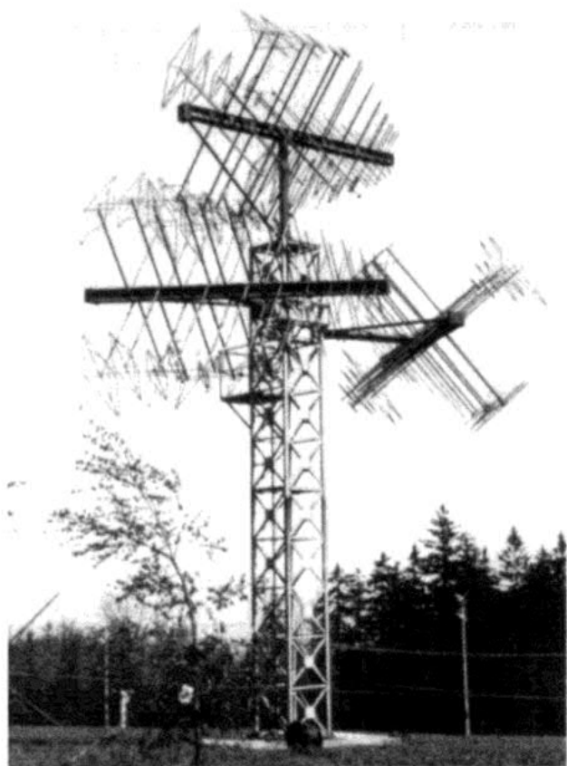
Bild 8: Die „Interims-VHF-Antenne“ HL 017 der Firma Rohde & Schwarz.
