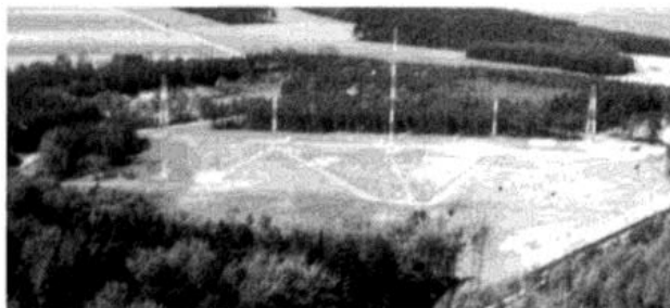
Bild 10: Das HF-Antennenfeld neben der B 71 bei Rotenburg (Wümme): Zwei horizontal polarisierte l/p-Antennen und eine l/p-Vertikalantenne mit „Hauptverkehrsazimut“ Ost.
