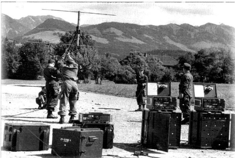
Bild 1: Aufbau einer Richtfunkendstelle AN/TRC-3 beim Fernmeldelehrbataillon Sonthofen im Jahr 1956.
