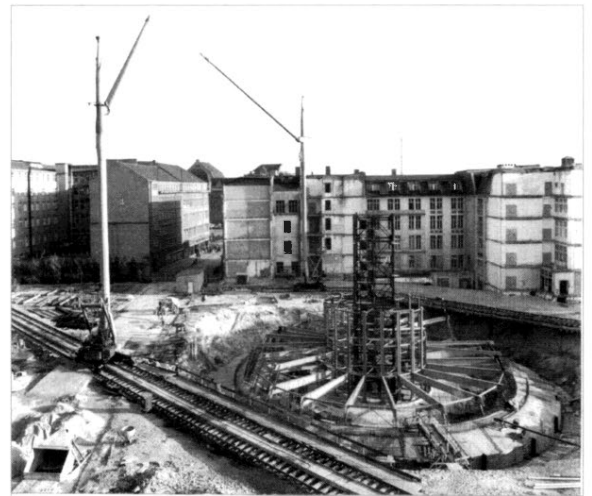
Bild 6: Ringfundament im Oktober 1965.
