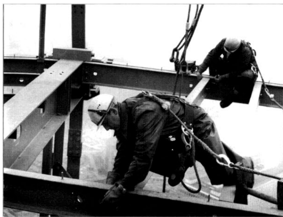
Bild 8: Montage der Eisenträger, die die Kugel tragen im April 1968.
