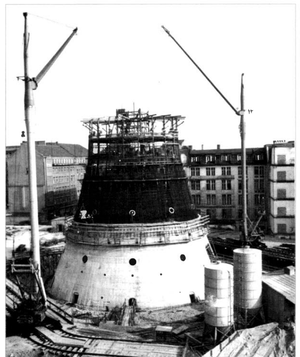
Bild 7: Abschnittsweise gegossener Turm.
