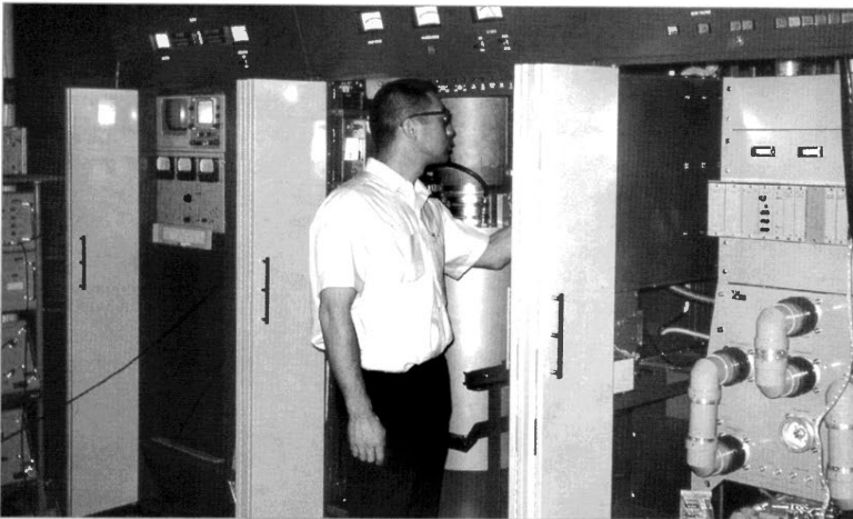
Bild 22: Der Chefsingenieur DAN N. KIMM der Firma Visual Electronics in Sunnyvale vor dem ersten 55/11 kW-Fernsehsender mit Vorstufe und Einkabelweiche von SEL in Deutschland .
