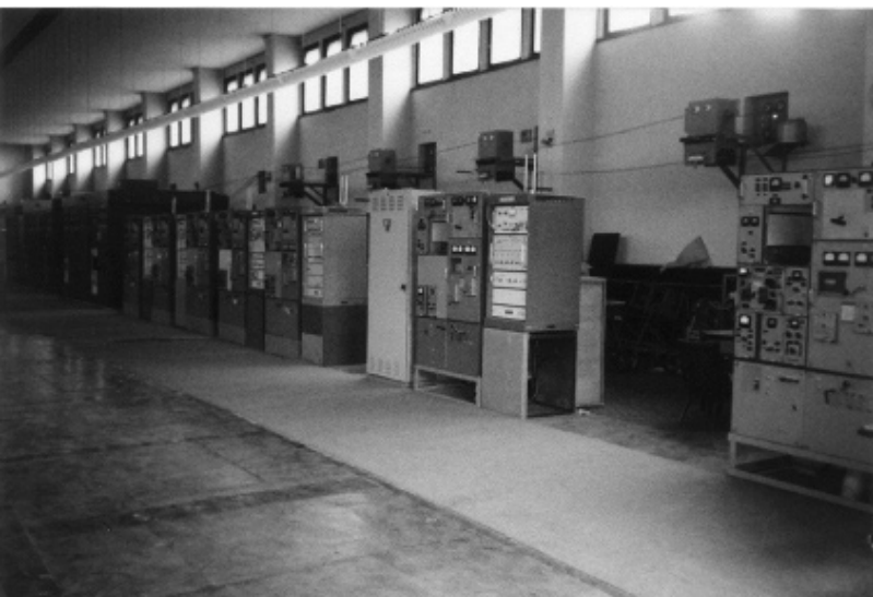
Bild 8: Die Westwand der Sendehalle der Funkstelle Zeesen.
