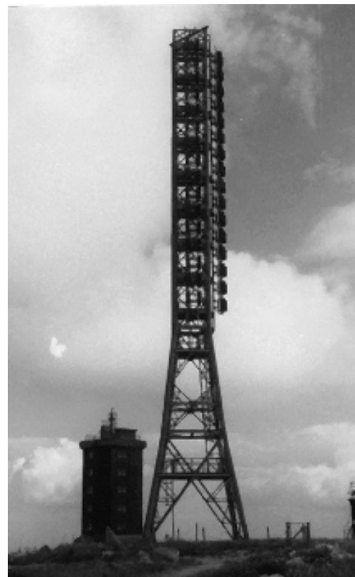
Bild 20: Hochgewinn-Empfangsantenne für das System „Horizont“ auf dem Brocken im Harz.
