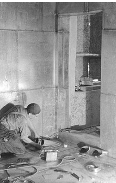
Bild 3: Gestaltung der Kabelein- und -ausführungen und der Türdichtungen.
