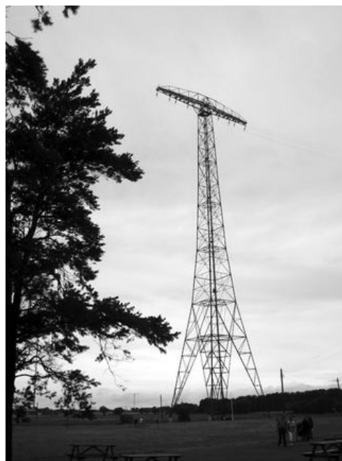
Bild 14: Einer der sechs 127 m hohen Antennentürme. Bild: U. Gumpert
