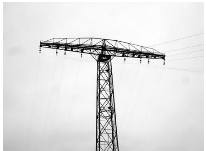
Bild 15: Der Querträger ist 46 m breit und begehbar. Bild: U. Gumpert
