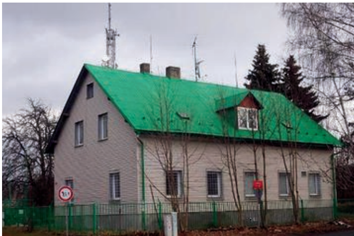
Bild 14. Das Sendergebäude in Nova Ruda, heutiger Zustand, im Hintergrund ein Sendemast, der für Mobilfunk u. ä. genutzt wird.
