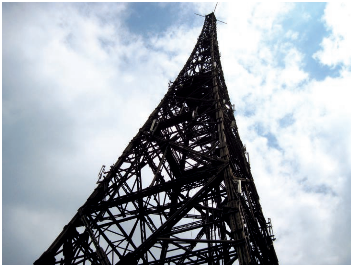
Der Sendeturm ist 111 m hoch, ist aus Lärchenholz gefertigt und wird mit 16.000 Schrauben aus Bronze zusammengehalten.
