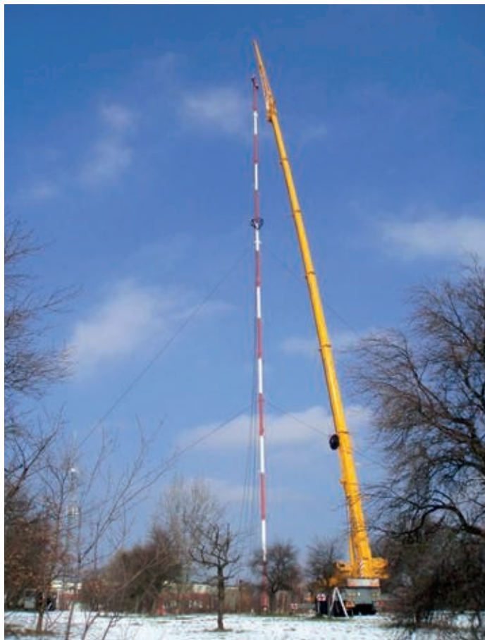
Bild 13. Demontage des Sendemastes in Nova Ruda im Jahr 2010.
