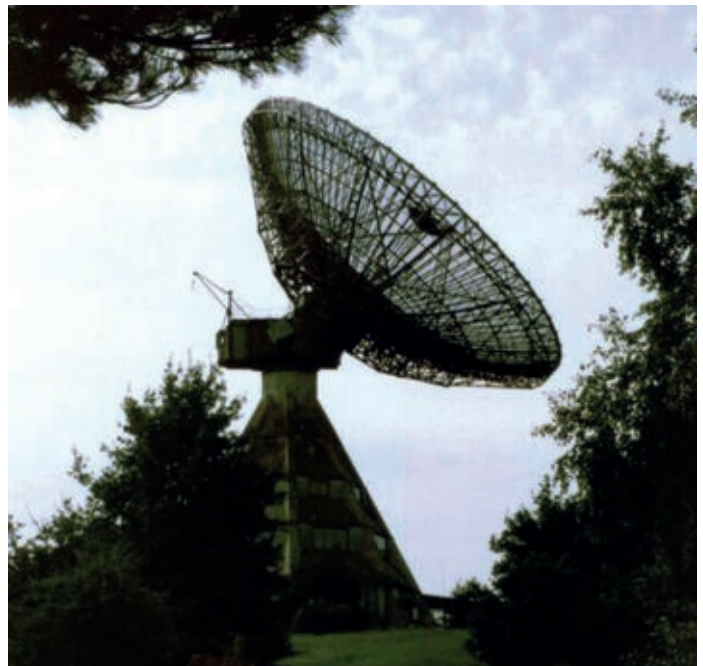
Bild 10: Deutschlands erstes Radioteleskop auf dem Berg Stockert in der Eifel. Die Projektierungsarbeiten begannen bereits 1953, und die Anlage sollte universell zu gebrauchen sein, d. h. außer astronomischen Beobachtungen auch Ausbreitungsversuche mit Funkwellen. Eine parallaktische Lagerung des Parabolspiegels wäre zu aufwendig gewesen. Beim Bau waren hauptsächlich Telefunken, AEG und die Metallwerke Friedrichshafen (ehemals Zeppelinwerke) beteiligt.
