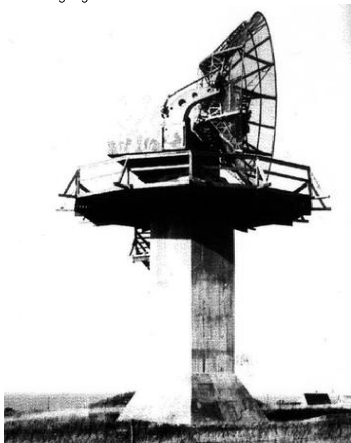
Bild 3. Einer der beiden „Würzburg-Riesen“, die 1944 bei Hantsholm (an der Nordspitze von Dänemark) zur Bewachung des Skagerrak aufgestellt wurden, befand sich auf einem 10 m hohen Betonturm (der zweite auf einem, der 4 m hoch war). Bild aus [3]
