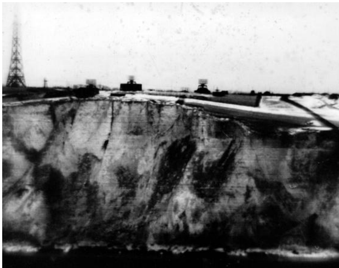
Bild 2. Foto vom 20.02.1942. Deutlich zu erkennen sind hier auch einige Antennen des „Low Level-Radars“ (rechts), das mit kleineren Wellenlängen arbeitete. Die Aufnahmen wurden über eine Entfernung von etwa 45 km mit einem Teleobjektiv mit einer Brennweite von 21 Metern (!) gemacht. Bild: Sammlung Sorgenfrei
