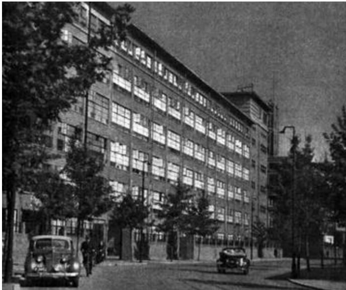
Bild 4. „The White Lady“, so wurde der riesige Gebäudekomplex am Emmasingel in Eindhoven genannt. Im 4. Stock befanden sich die Röhren-Entwicklungsgruppen und eine Röhrenfabrikation. Hier ist auch der Ursprung der EF50.
