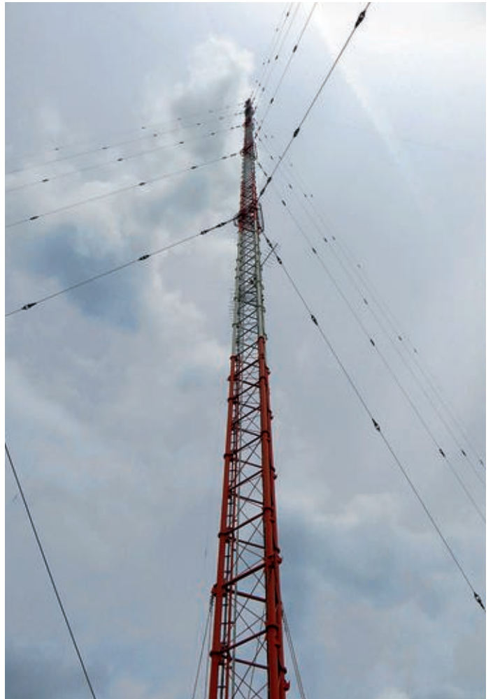
Die Antenne ist an einem 359,7 m hohen Mast aufgehängt.
