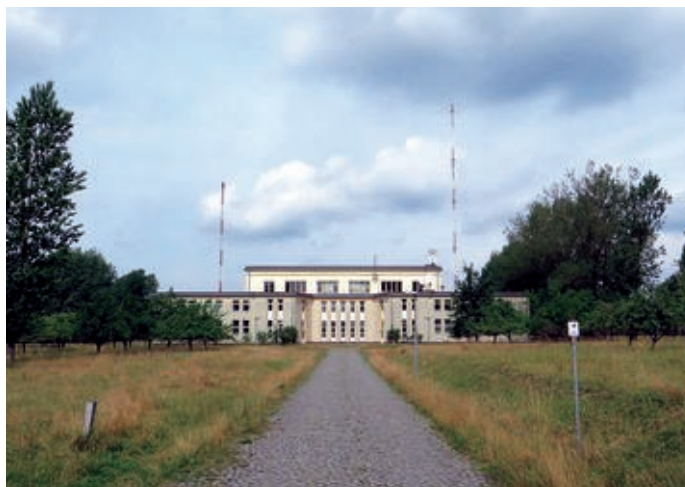
Das riesige Gelände mit einem fast leeren, aber gewaltigen Senderhaus.
