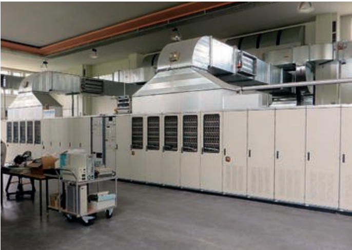
Im Stationsgebäude das Prunkstück dieses Standortes: Ein Sender mit je zwei modular aufgebauten Transistor-Endstufen Transradio TRAM 250L.
