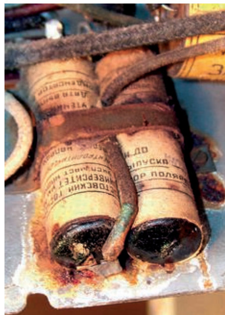
Bild 6. Zwei Elkos, die am Chassis montiert sind, waren ausgelaufen.
