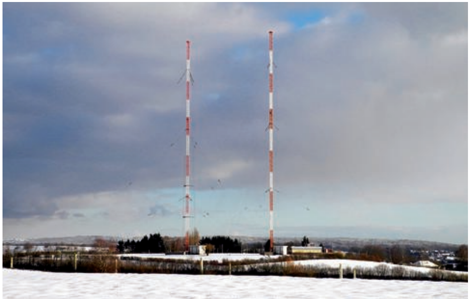
Bild 3. Der komplette Sendekomplex. Am linken Mast ist die Antenne deutlich erkennbar. Der rechte, ältere Mast dient heute als Reflektor. Rechts neben dem Reflektormast befindet sich das Technik- und Verwaltungsgebäude. Im Vordergrund kann man auch die Stützen der Autobahnabschirmung erkennen.
