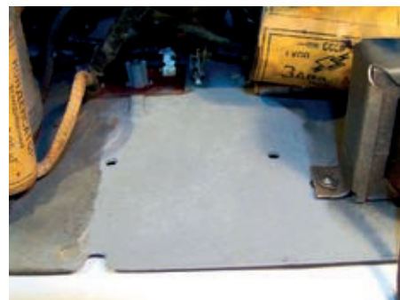
Bild 7. Der Rost wurde vom Chassis entfernt und die Stelle mit Zinklack aus der Spraydose lackiert.
