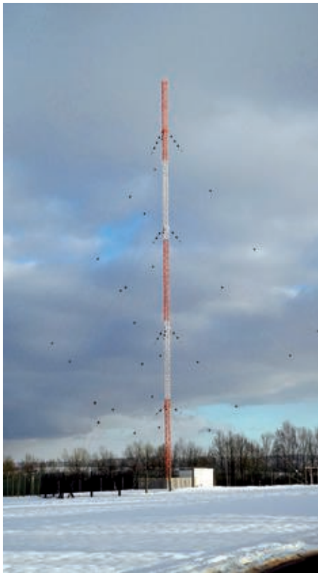
Bild 2. Die 50 m hohe Behelfsantenne, erbaut 1946. Seit 2005 wird von hier das eigenständige Rundfunkprogramm „Antenne Saar“ ausgestrahlt.
