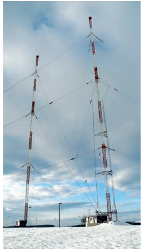
Bild 1. Die beiden 120 m hohen Antennenmasten der Sendeanlage Heusweiler. Rechts befindet sich der aktive Strahler, der linke Mast dient als Reflektor.
