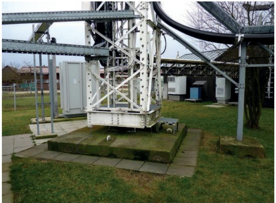
Bild 10: Sockel und Einspeisungen, Ansicht aus NO. Die Kabel sind wegen der Gefahr herabfallender Eisbrocken abgedeckt.
