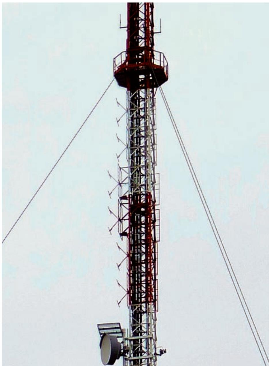
Bild 7: Detailansicht mit den UKW-Antennen für vier Radioprogramme, Ansicht aus SO. Haupt-Abstrahlrichtung 240 bis 360 Grad. Oberhalb der Plattform in 90 m Höhe gut sichtbar die beiden 70-cm-Amateurfunkantennen des Relais DB0HRW
