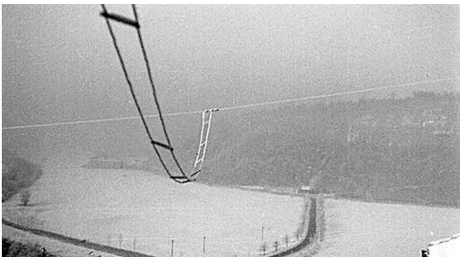
Bild 11. Zeppelin-Antenne mit abgestimmter Speiseleitung konnte in recht günstiger Position aufgehängt werden.
