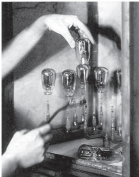
Bild 25. Abschmelzen „Abziehen“ der fertig gepumpten Röhren. (aus W. Espe, M. Knoll)
