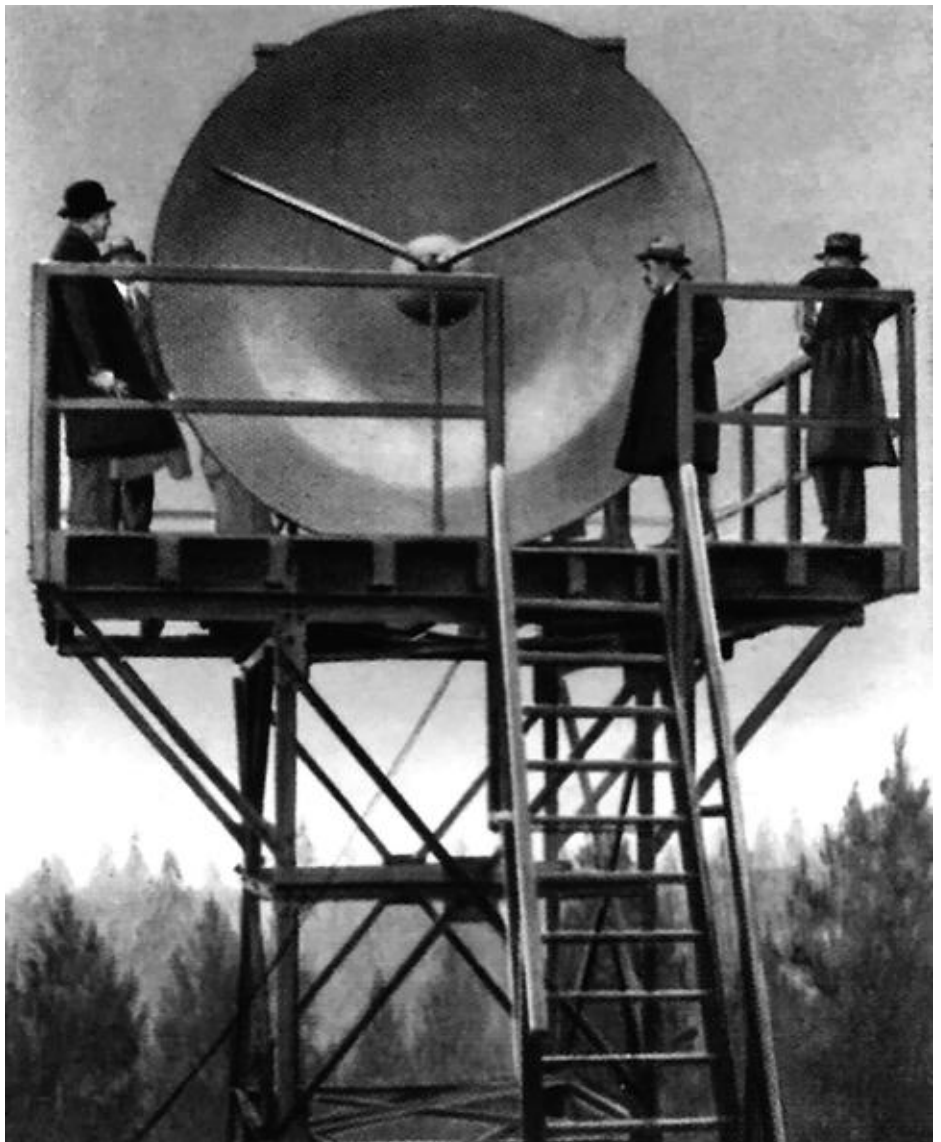
Bild 10. Parabolspiegel in St. Inglevert (aus: Emerson, A.: Radio Yesterday; Cross-channel microwave 1934 style, Ham Radio Today, Januar 1983).
