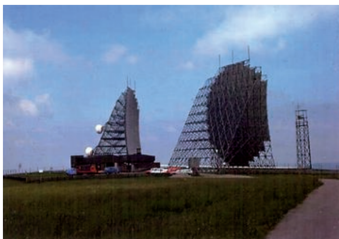
Bild 13. Die Station AFEZ auf dem Feldberg. [1]
