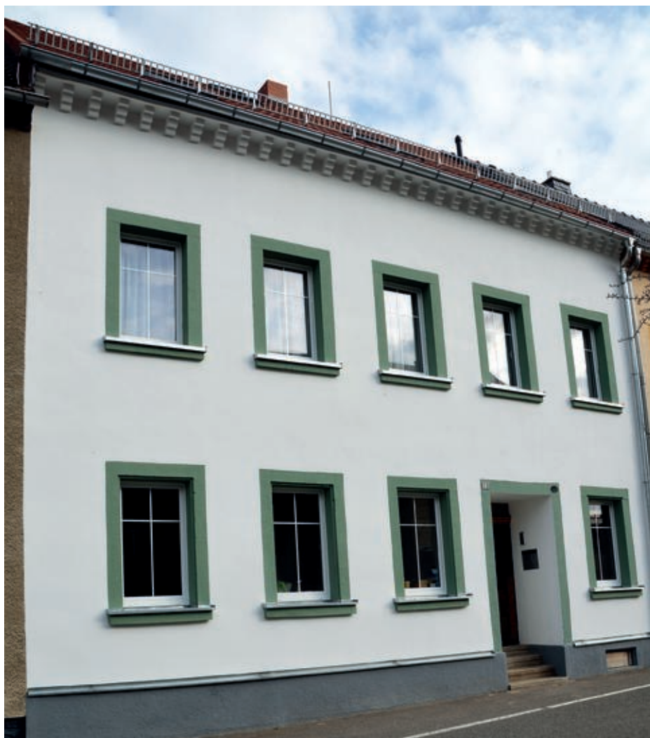
In diesem frisch renovierten Gebäude in Hainichen befindet sich jetzt das GFGF-Archiv.
