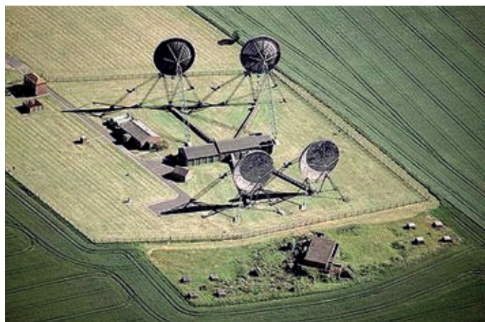
Bild 5. Tropo-Relaistelle Stenigot (UBIZ) auf dem Manor Hill. Auf der Luftaufnahme vorn deutlich sichtbar auch noch die Reste der früheren Radarstation der Chain Home aus dem 2. Weltkrieg: Betriebsgebäude und Fundamente der beiden Antennentürme. [7]
