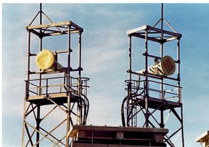
Bild 8. Horn-Erreger der Tropo-Antennen. [12]
