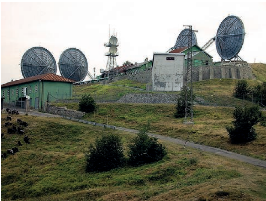
Bild 3. Typische Relaisstation mit vier Troposcatter-Richtantennen und einem Antennenturm mit den Mikrowellen-Richtfunkantennen (hier: Station „Livorno“ auf dem Monte Giogo in Italien). [10]
