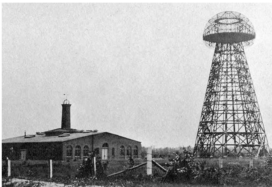
Bild 10. Mit dem „Wardenclyffe Tower“ (1904) wollte Tesla drahtlos Energie übertragen, aber auch telegrafieren.
