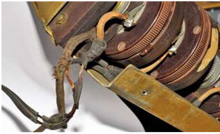
Bild 13. Kabelanschluss der „Zeitsuper“-Schaltmechanik vor der Restaurierung.
