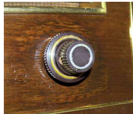
Bild 3: Furnierschaden am Lautstärkeregler nach der Restauration
