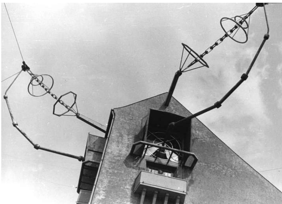
Sendehauptgebäude mit Variometerturm und Antennenzuleitungen
