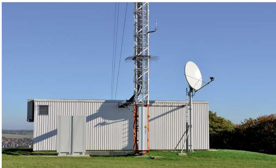
Bild 9: Heutige Sendestelle Weimar Belvedere, bestehend aus einem Container mit Sendetechnik und einem 50 m hohen Stahlgittermast als Antennenträger
