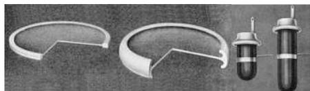
Bild 28: Keramische Kondensatoren für Nachrichtensender und Industriegeratoren, etwa 1935. Links Scheiben-, rechts Topfkondensatoren, Fabrikat Hescho [24]
