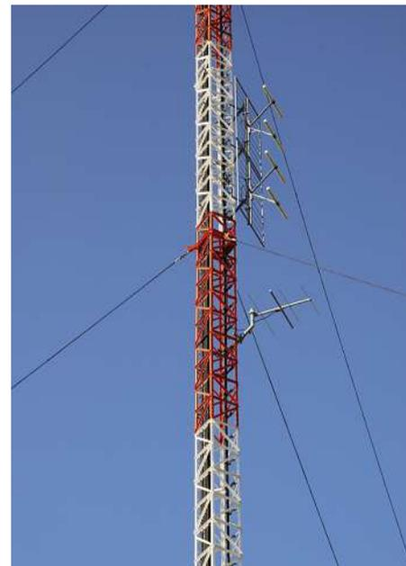
Bild 7: Nahaufnahme der Dipolgruppe und einer von zwei Yagi-Antennen in Weimar Belvedere
