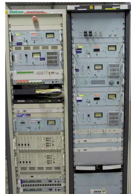
Bild 8: UKW-Sender und Steuereinrichtungen in Weimar Belvedere im ehemaligen Stationsgebäude
