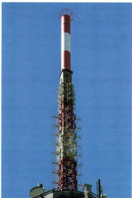
Bild 5: GFK-Rohr mit vertikal polarisierten Dipolen für DVB-T, in der Mitte vertikal polarisierte Dipole für DAB+, unten horizontal polarisierte Yagi-Antennen für UKW Band II
