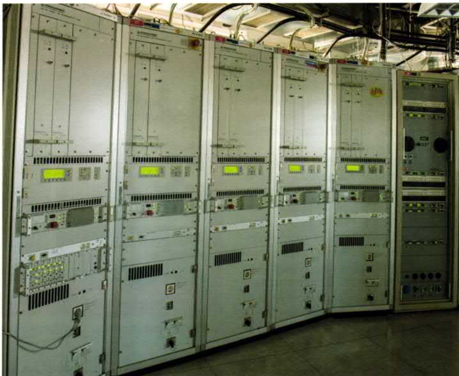
Bild 6: UKW-Sender Band II
