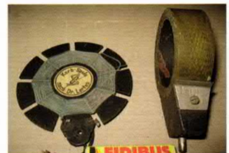
Bild 18: Korbbodenspule mit Drahtanschlüssen und Honigwabenspule mit englischem Sockel, um 1928
