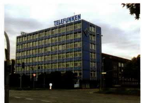
Bild 2: Ehemaliges Verwaltungsgebäude von Telefunken in Hannover Bild: Wikipedia
