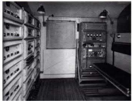
Bild 6: Innenraum des Gerätwagens vom Richtverbindungsgerät Stuttgart
